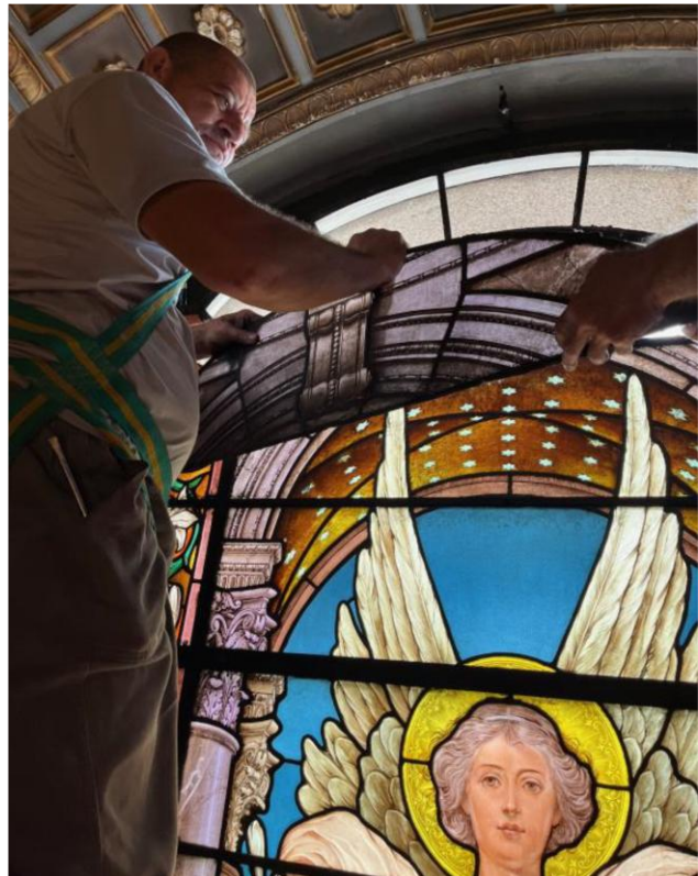
Figura 22 e 23 - Preparo da placa para proteção dos vãos e o início da ação de remoção dos painéis.
