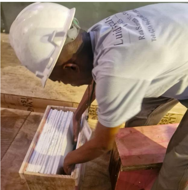
Figuras 25 e 26 - Movimentação vertical dos painéis dos vitrais e início das embalagens para o transporte.
