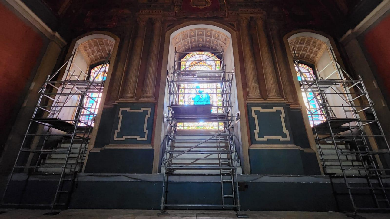
Figura 15 – Aspecto das três torres de andaimes montadas para dar acesso aos vitrais a serem restaurados.
