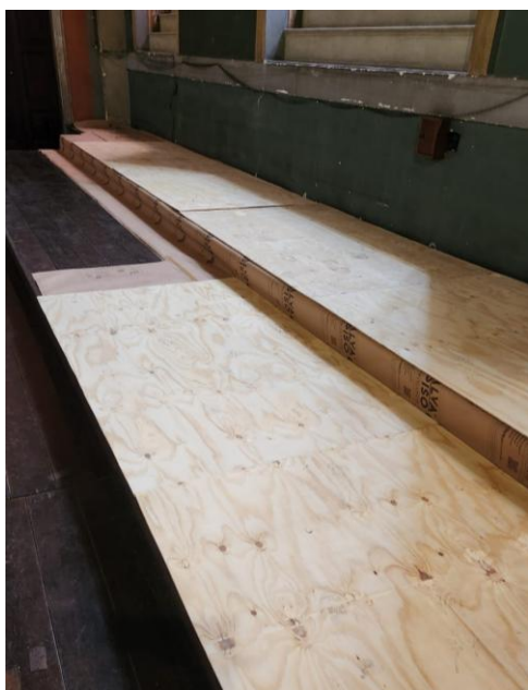
Figura 14 - Piso em madeira do coro da igreja com instalação de proteção física antes da montagem dos andaimes
