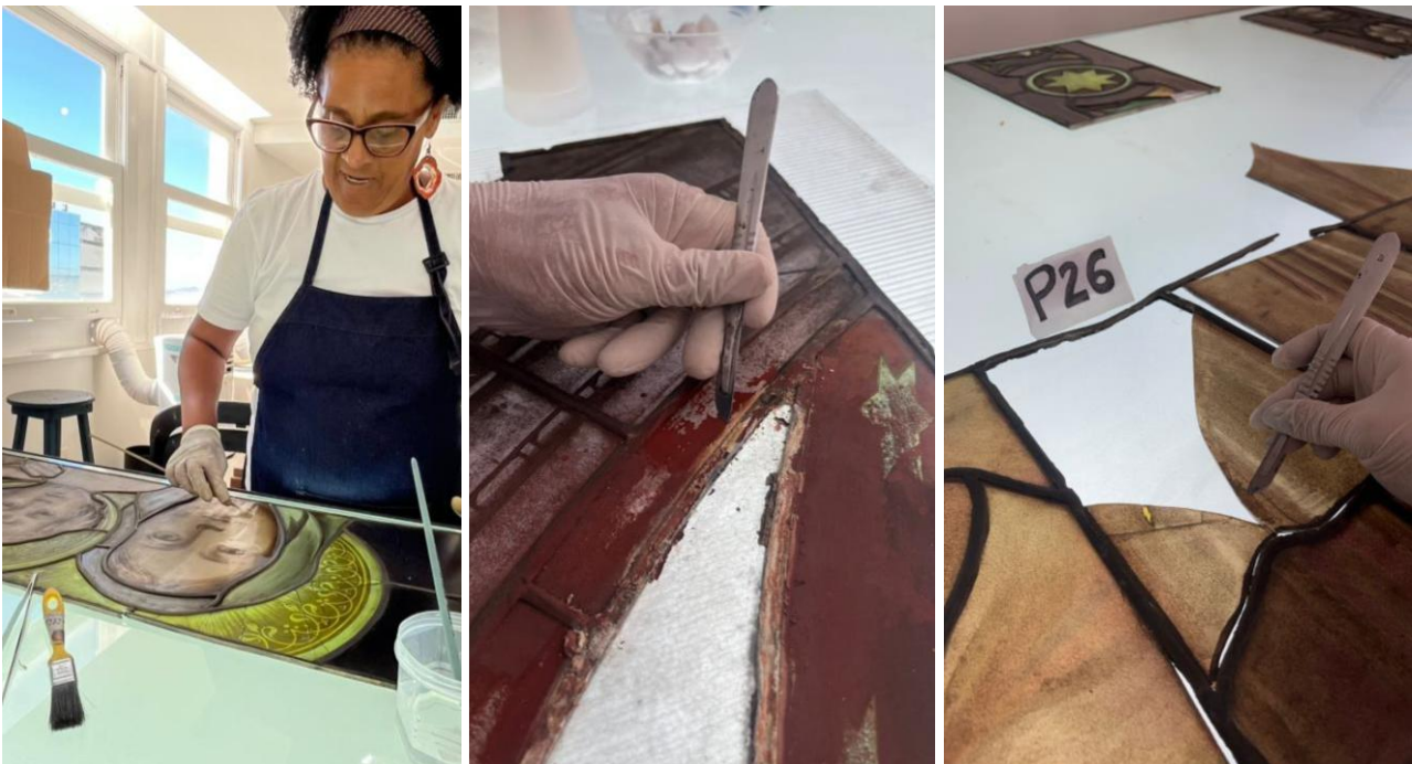
Figuras 28, 29 e 30 – Procedimentos para limpeza técnica dos painéis de vidro e chumbo.
