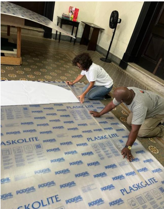
Figura 22 e 23 - Preparo da placa para proteção dos vãos e o início da ação de remoção dos painéis.
