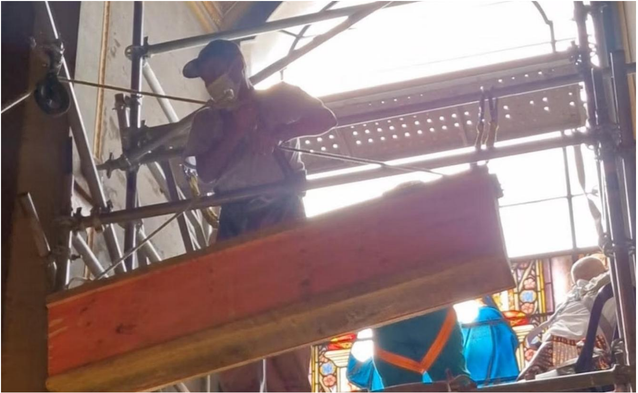
Figuras 25 e 26 - Movimentação vertical dos painéis dos vitrais e início das embalagens para o transporte.
