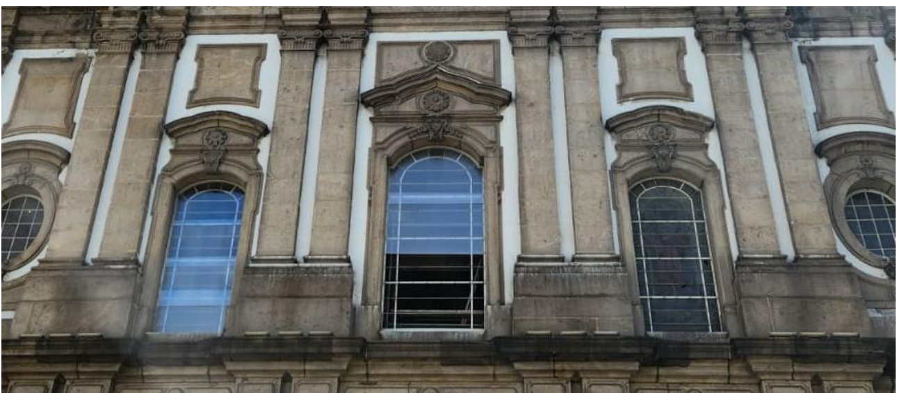
Figura 24 - Aspecto da fachada da Igreja da Candelária durante a remoção dos painéis dos vitrais.
