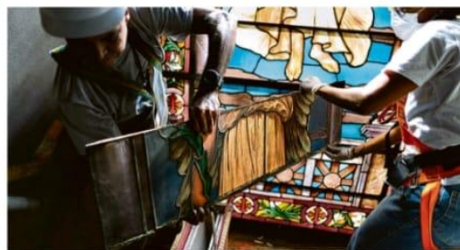
Cuidado. Restauradores removem uma das peças que passarão por manutenção: os vitrais foram divididos em 111 pedaços
