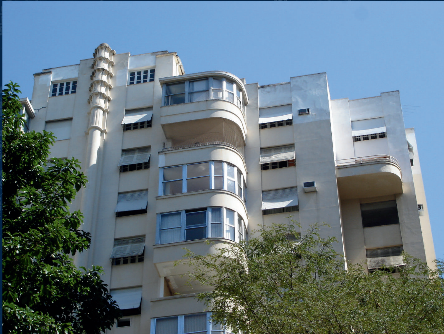
Rua Senador Vergueiro nº 92, Flamengo, Ed. Capibaribe. Projetado e construído por Oliveira Lima & Cia.Ltda (1937)
