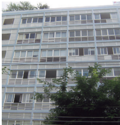
Imóvel, na Rua Benjamim Batista, 180;
