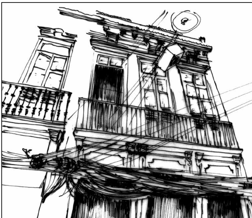
Excesso de fiação passando pela fachada do imóvel
