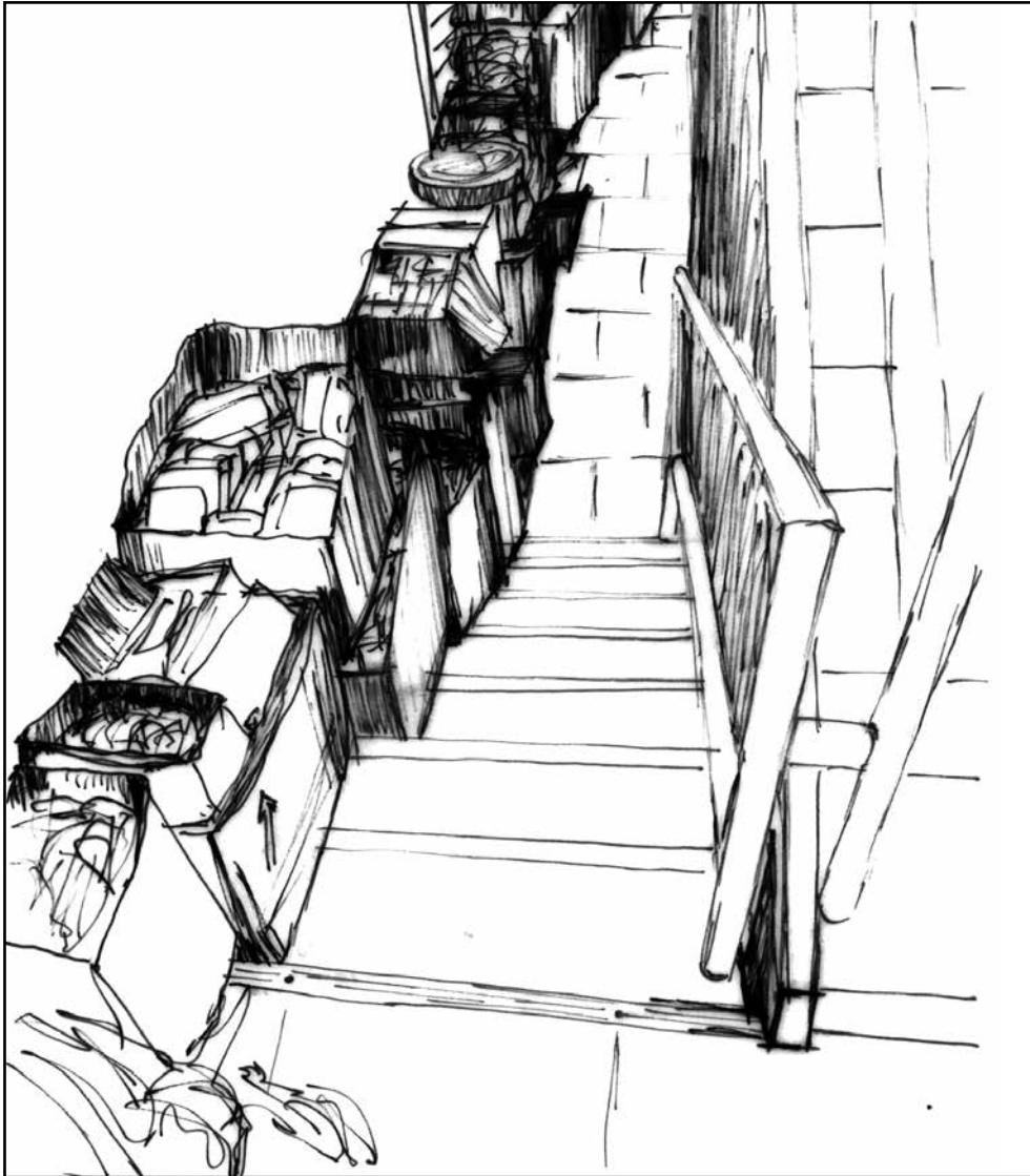
Escada utilizada como depósito de caixas, obstruindo o acesso à saída de emergência
