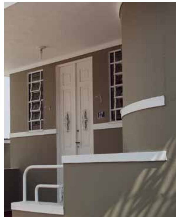
Residência no Méier
