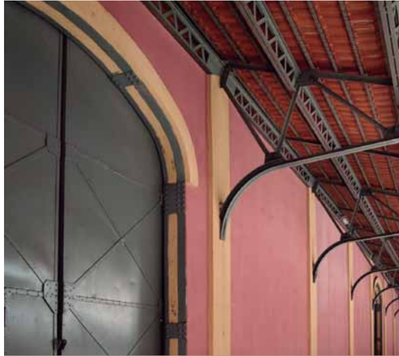
Armazém do Cais do Porto
