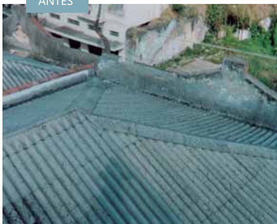
Telhado em fibrocimento antes do restauro
