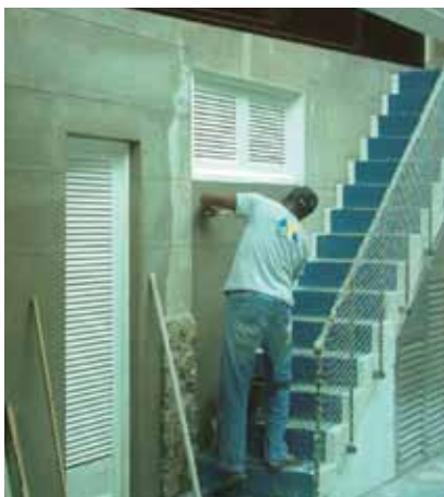
Processo de execução do revestimento em pó-de-pedra
