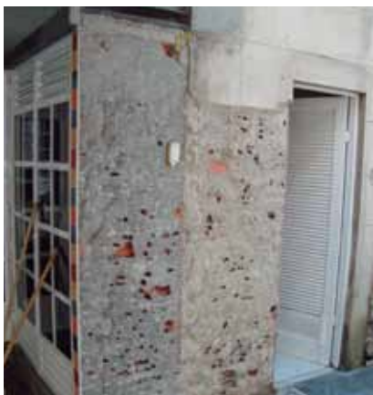
Parede sendo preparada para receber o revestimento em pó-de-pedra
