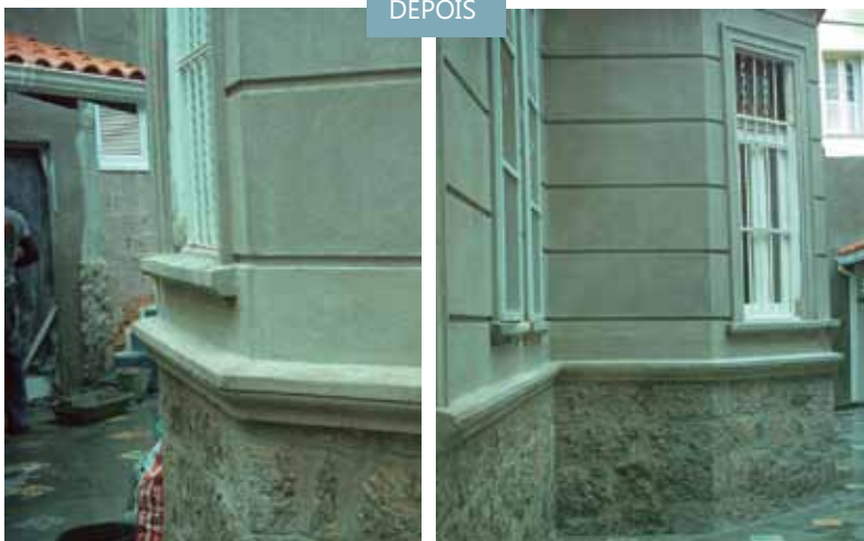
Situação após restauro – com instalações prediais embutidas
