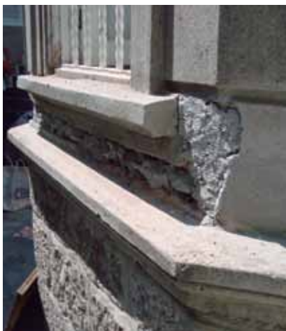
Retirada do revestimento comprometido
