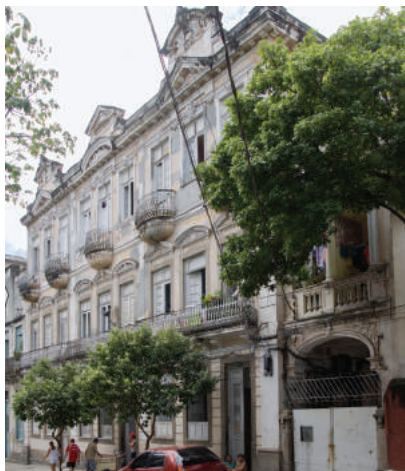
Edificação , na Rua Bento Lisboa, 72
