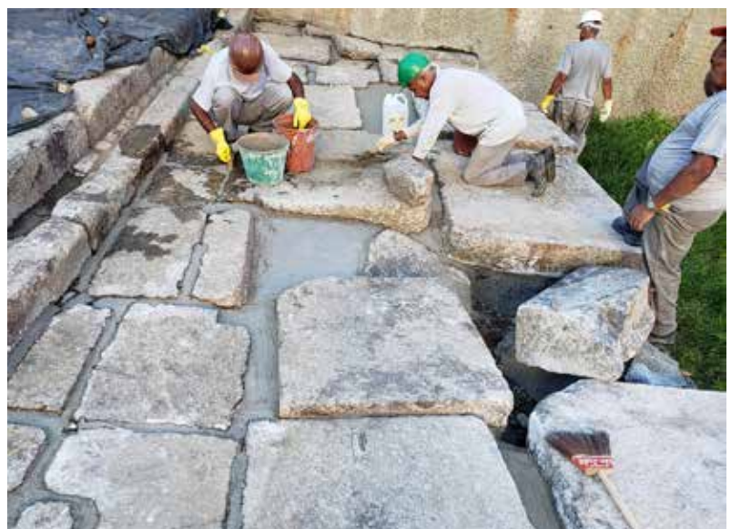
Obras de consolidação do Cais do Valongo, realizadas em 2019
